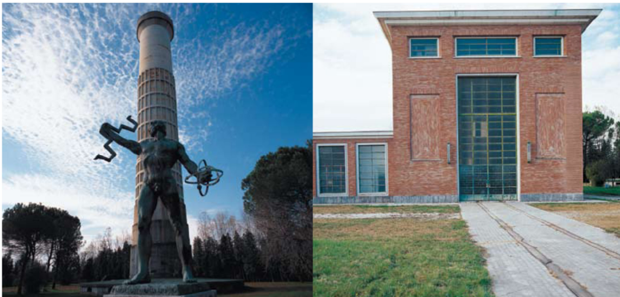
La Torre piezometrica e il fabbricato centrale
