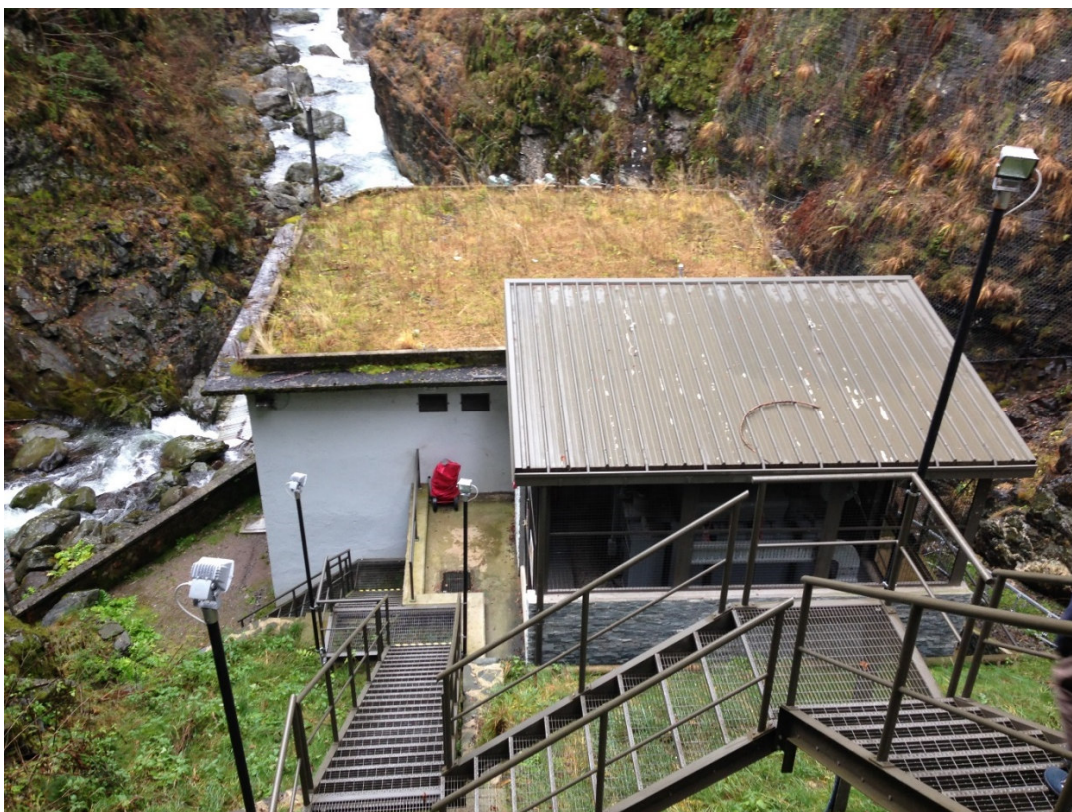
L'impianto di Fontanamora
