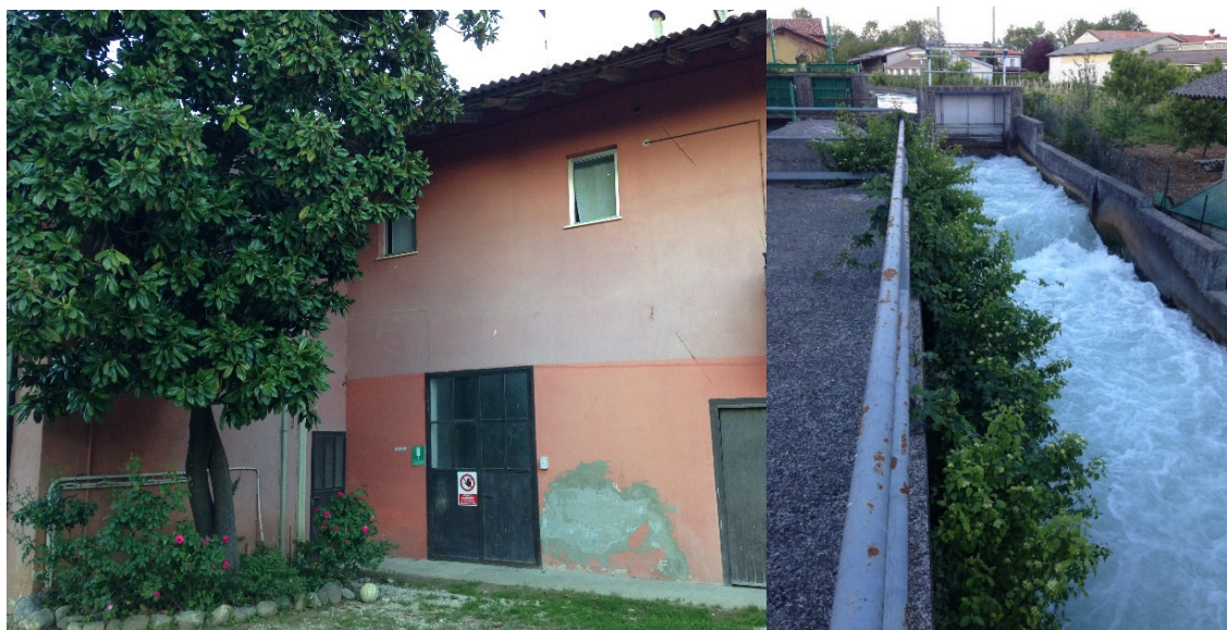
Ingresso della centrale e canale di scarico
