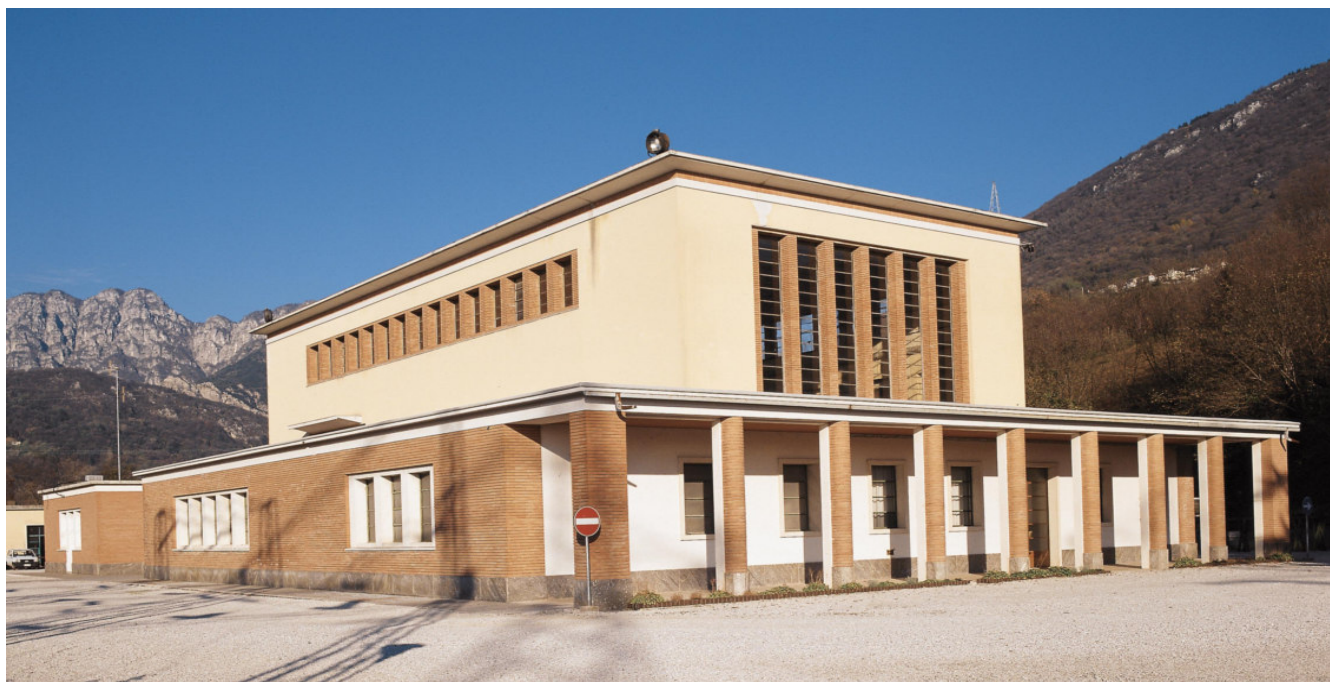
Impianto di Meduno
