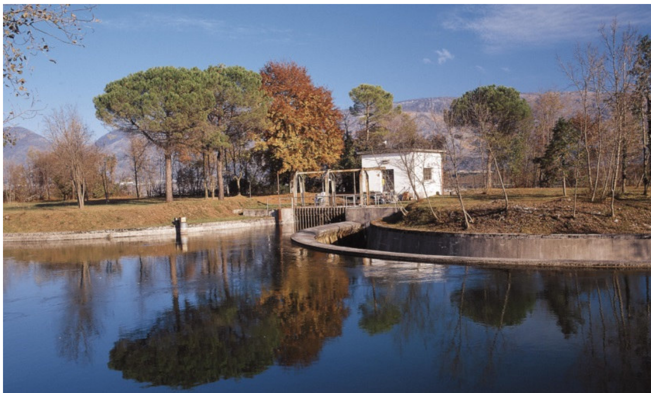
Opera di presa di Colle
